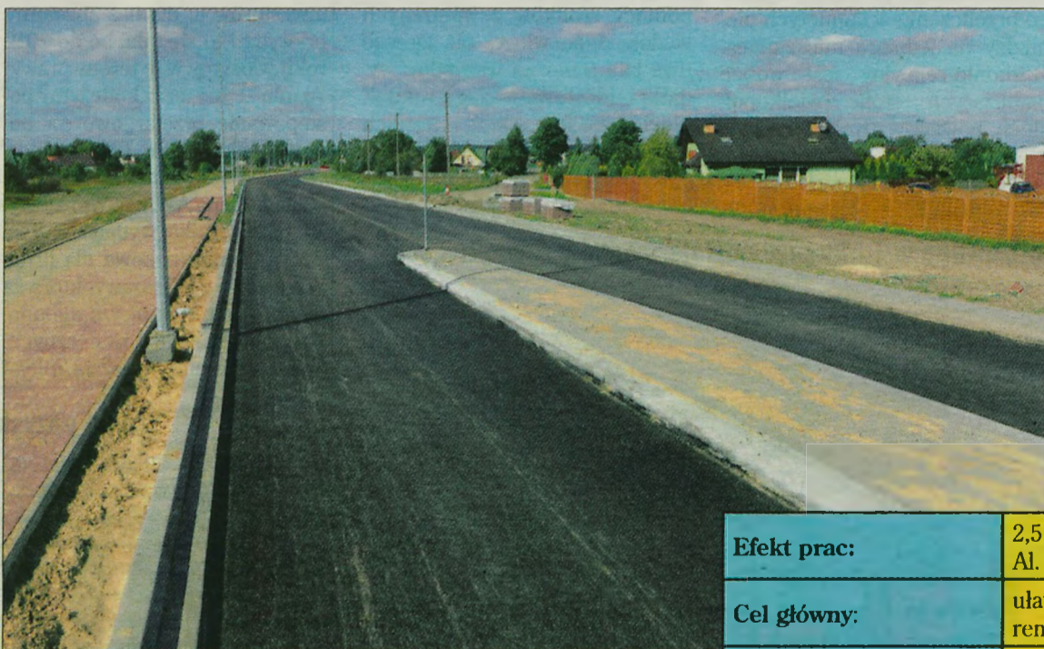
Na drodze wylano już pierwsze warstwy asfaltu
