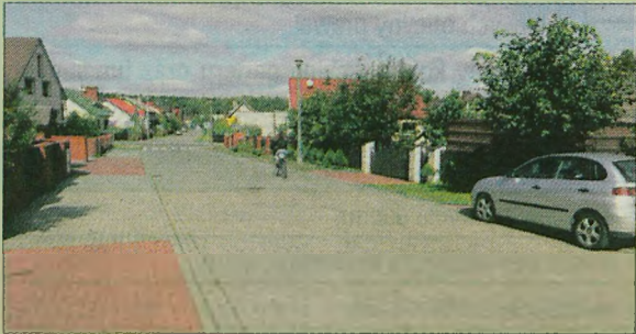
Nowy odcinek ul. Paderewskiego na Zdrojkach
