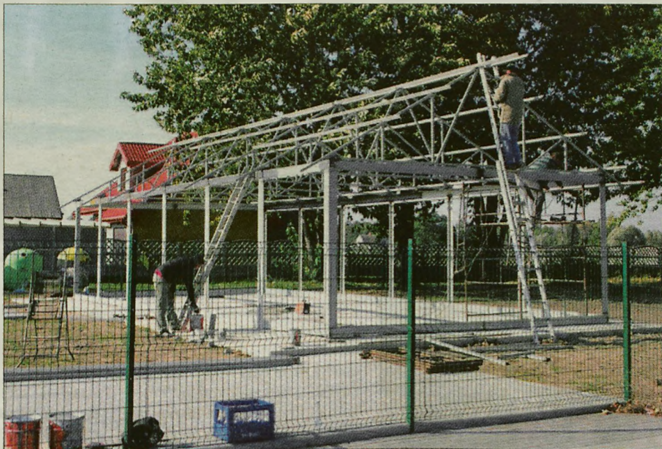
Na budowie świetlicy i placu zabaw w Rogowie
