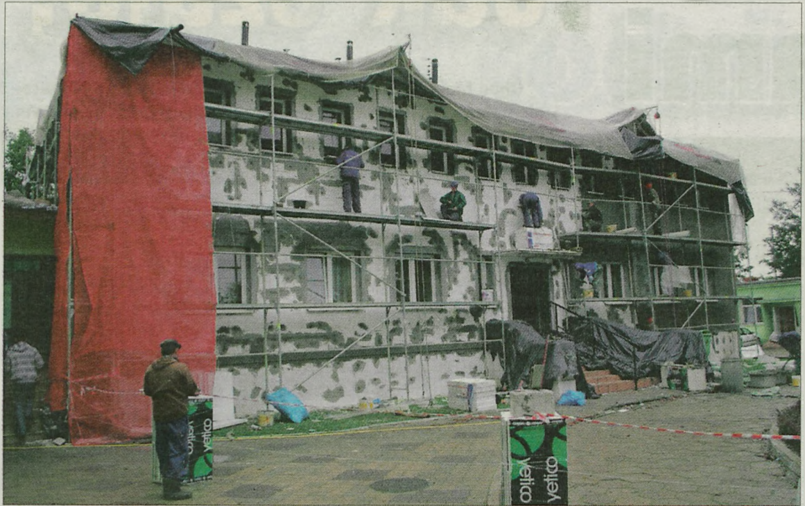
Robotnicy kończą termomodernizację internatu.
