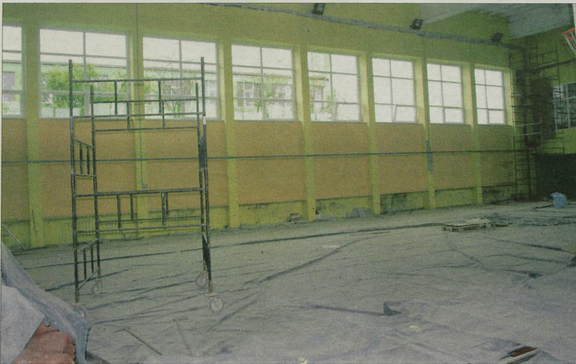
Na hali pozostało jeszcze malowanie.
