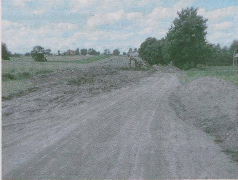
Droga przed budową
