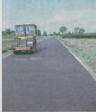
W trakcie budowy
