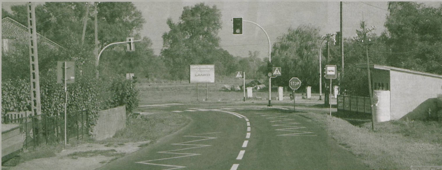
Sygnalizacja świetlna na skrzyżowaniu w Głuchowie.
