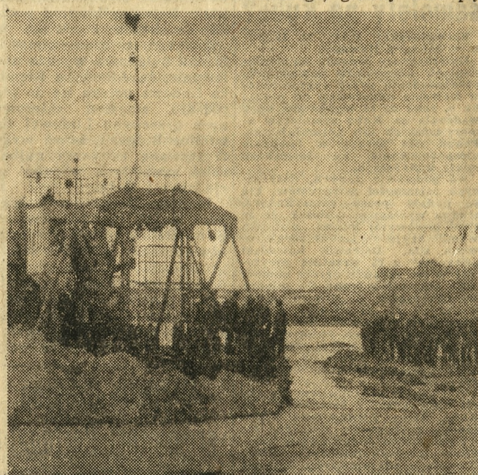
Przeszkoda ziemna przekopana. Warta coraz szerszym nurtem wlewa się w nowe koryto zaś pogłębiarka „Leda” usuwa dalsze zwaly ziemi.
