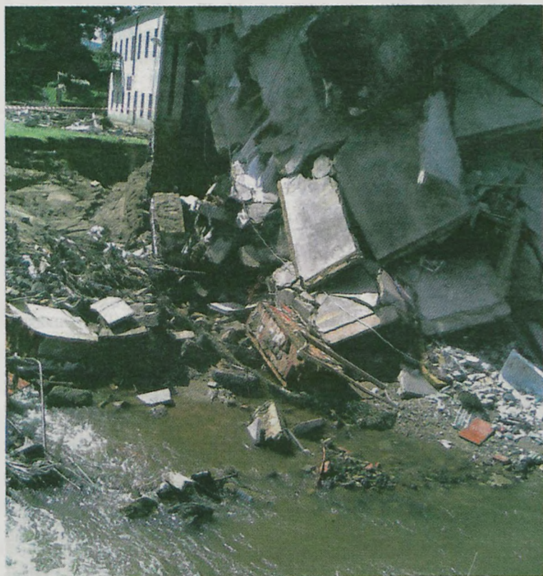
Bogatynia po przejściu fali powodziowej przypominała ziemię jak po wielkiej katastrofie.
