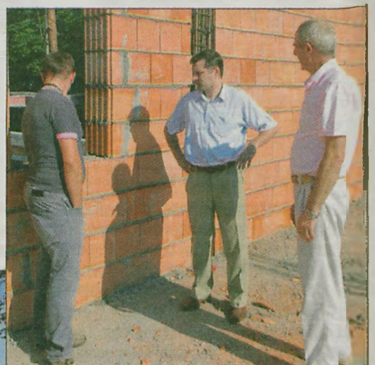
Burmistrz – Piątkowski (w środku) ze swoim zastępcą i inspektorem Świętochowskim na placu budowy.
