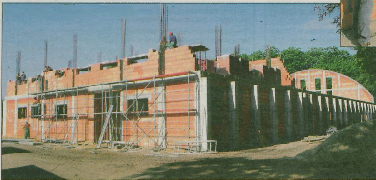
Potężna bryła hali widoczna jest już z daleka.
