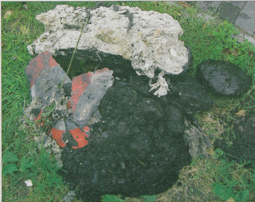
Zanieczyszczenia „wypchnięte” z kolektora kanalizacji sanitarnej w ul. P.O.W., a wśród nich zwały tłuszczu i znak drogowy...
