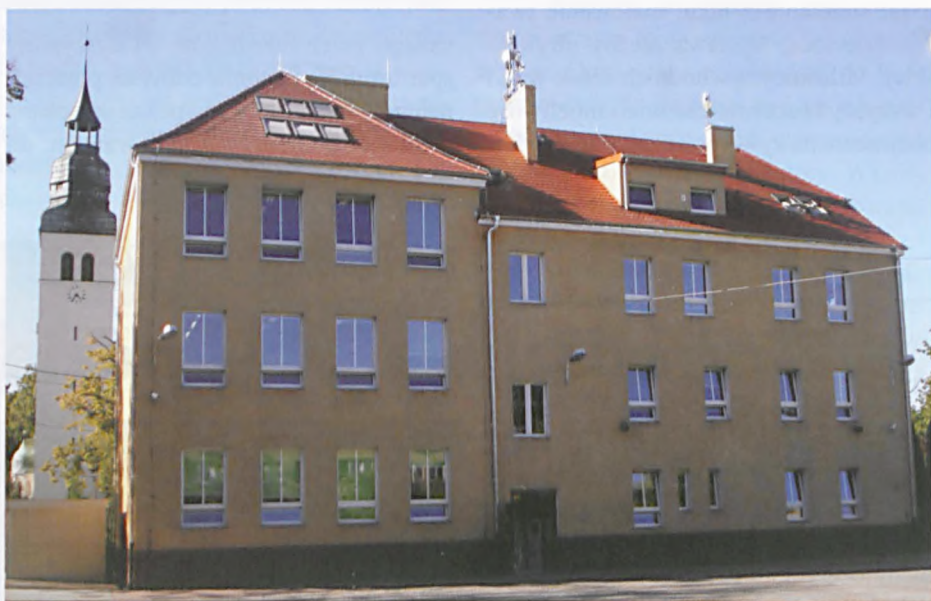
SP1 po wymianie dachówki,
