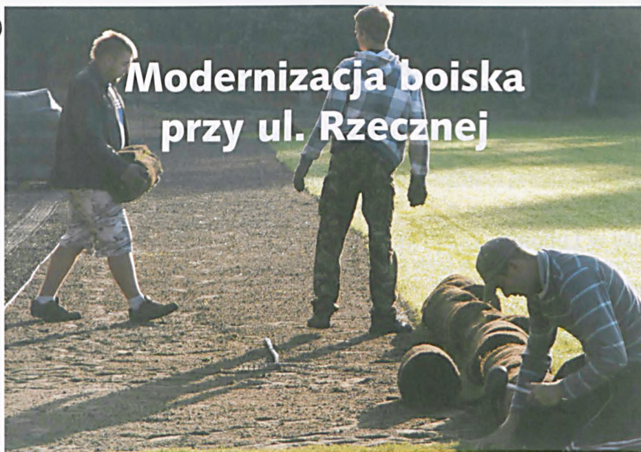
Prace przy modernizacji boiska
