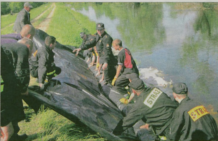
By zapobiec przeciekaniu wału strażacy układali ochronne folie.
