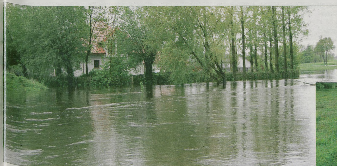
... zalała nowo wybudowany dom.
