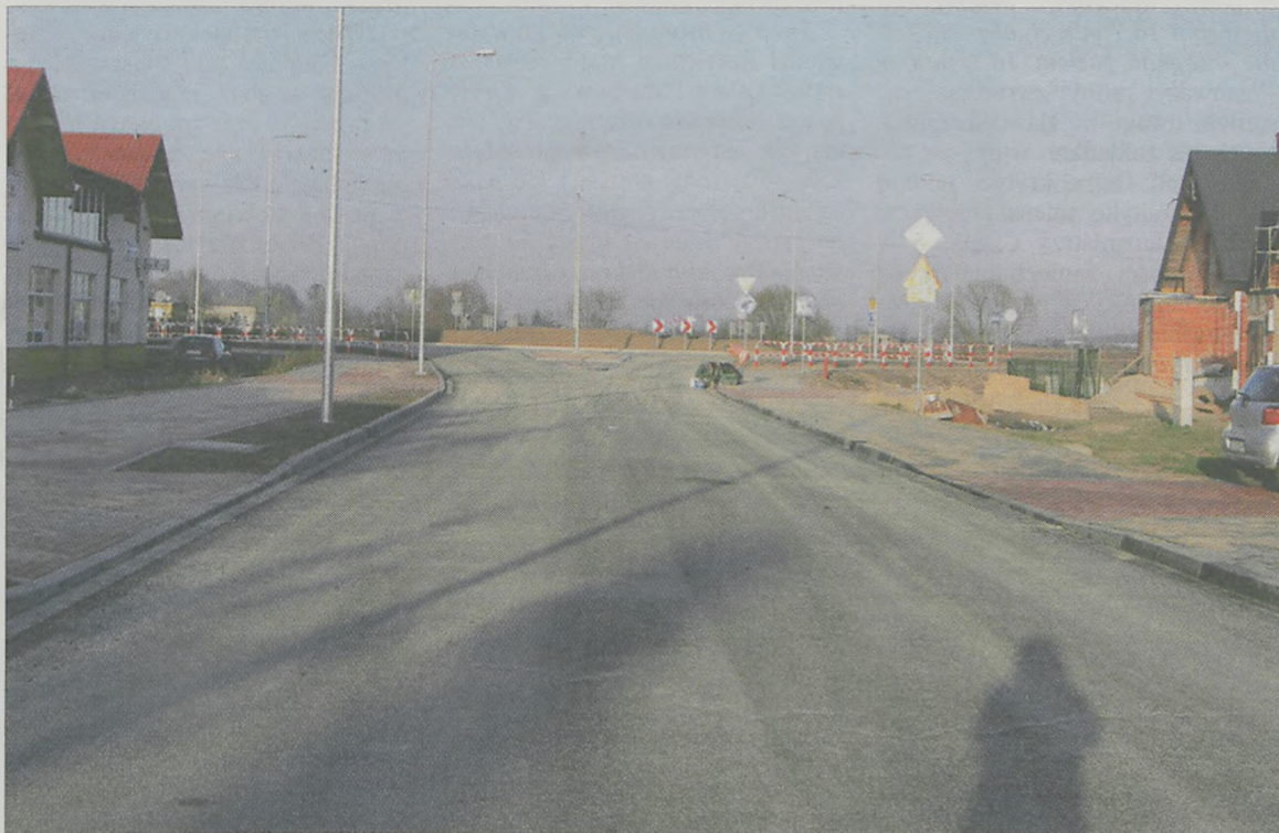
Od momentu oddania do użytku ronda na Uniejowskiej, ulica Słoneczna zmieniła całkowicie swój osiedlowy charakter.
