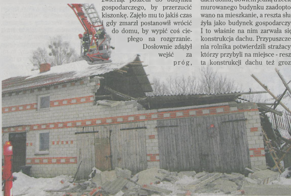
Strażacy usunęli resztę śniegu z dachu nad częścią mieszkalną budynku.
