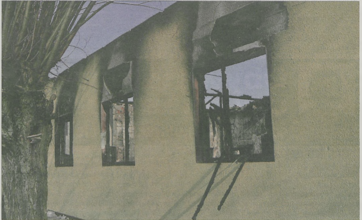
Budynek był odnawiany i remontowany, niedawno wstawiono nowe plastikowe okna.
