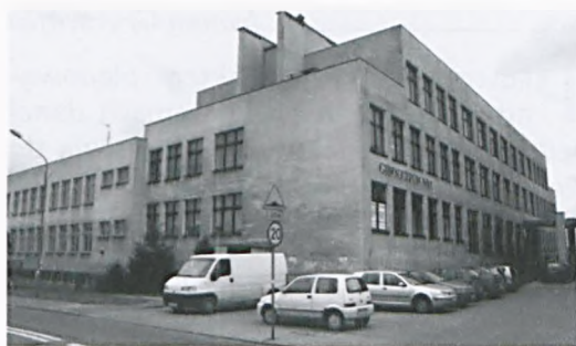
Budynek Szkoły Podstawowej nr 3 i Gimnazjum nr 1, który zostanie zmodernizowany za unijne pieniądze
