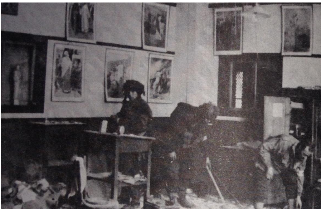
Szkoła w Driel, w której mieścił się Główny Punkt Opatrunkowy Brygady. Widoczne skutki ostrzału.
