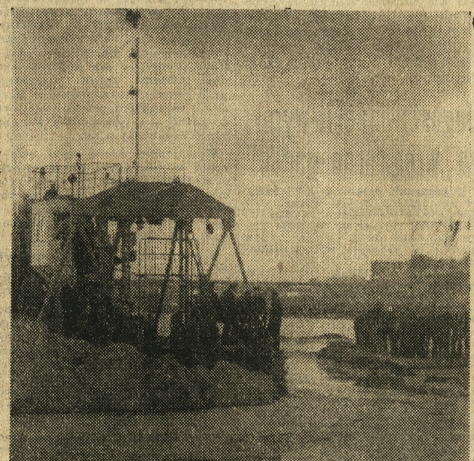
Przeszkoda ziemna przekopana. Warta coraz szerszym nurtem wlewa się w nowe koryto, zaś pogłębiarka „Leda” usuwa dalsze zwalę ziemi.
