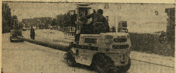
Na wszystko jest sposób, nawet na 20-metrowy element rumuńskiej wieży wiertniczej znajdzie się rada — transportują go dwa wózki widelkowe.
