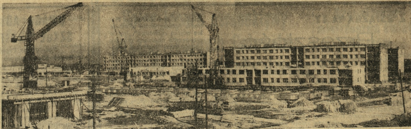
Domy wyrastają jak grzyby po deszczu. Powstają one metodą uprzemysłowioną — z wielkich płyt. Doświadczona załoga PPB nr 2 montuje jeden budynek w ciągu kilku tygodni. Obecna panorama nowych Rataj zmienia wkrótce wysokie budynki. Bo i tu projektuje się budowę wielu wieżowców.
