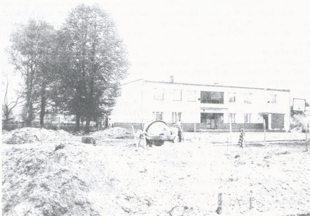
Rozbudowa szkoły w Miedzichowie
