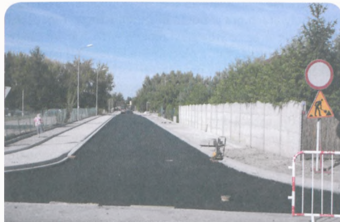
Budowa ulicy Szpitalnej
