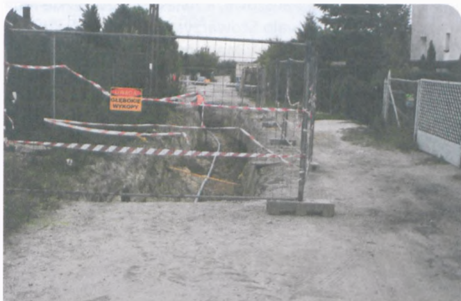
Budowa ulicy Klasztornej
