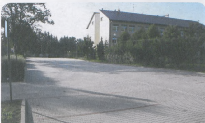
Parking przy SP 1
