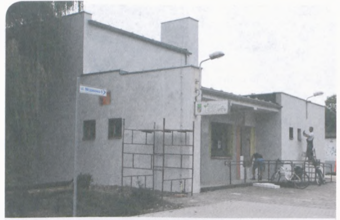
Adaptacja nastawni kolejowej
