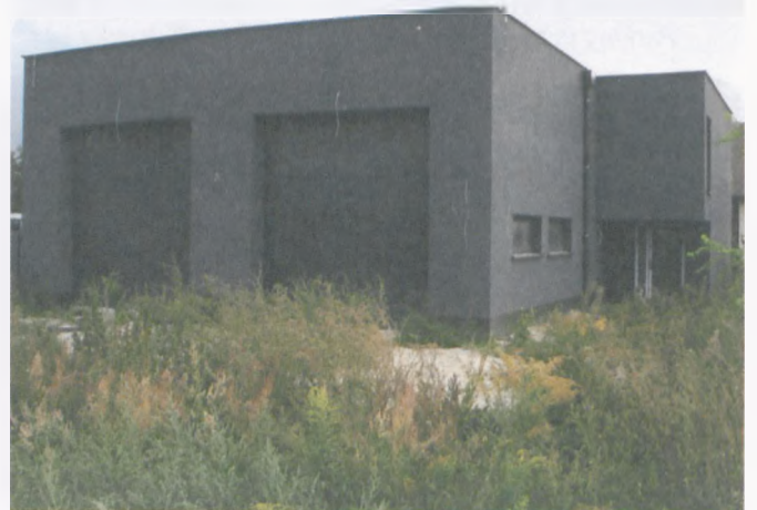
Budowa remizy strażackiej dla OSP
