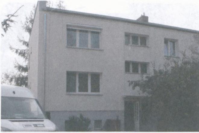
Termomodernizacja domu nauczyciela
