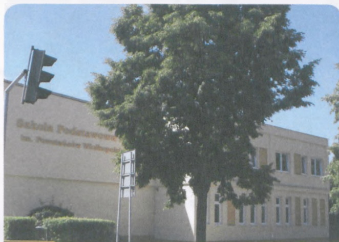
Rozbudowa SP 2 o sanitariaty
