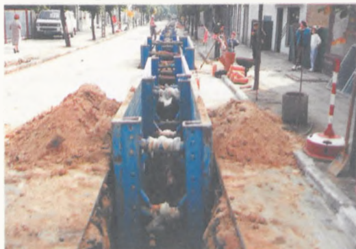
Budowa rurociągu w ulicy
