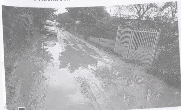
Tak wygląda ul. Nowa w porze deszczowej!
