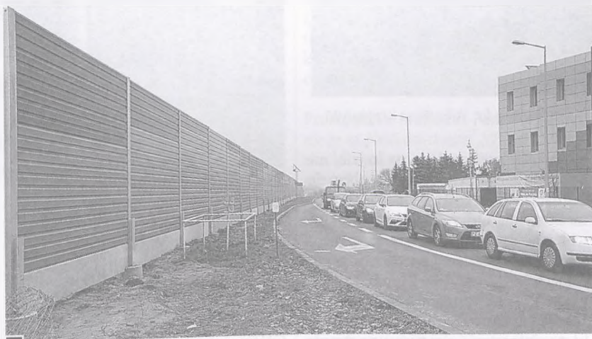
4-metrowej wysokości ekran przy skrzyżowaniu ul. Unijnej i Kościuszki, na wysokości Hotelu „Max”. Zgodnie z „Decyzją o środowiskowych uwarunkowaniach” przed hałasem ma chronić cała konstrukcja tej przegrody łącznie, tj. betonowa podwalina wraz z konstrukcją nośną i panelami akustycznymi
