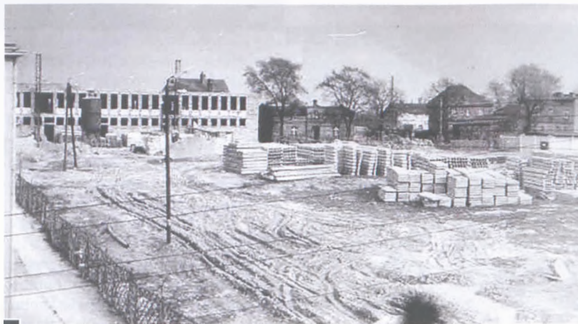
Budowa pawilonu przy ul. Żabikowskiej 62
