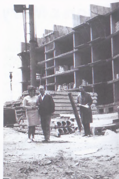
Budowa bloków przy ul. Żabikowskiej 62
