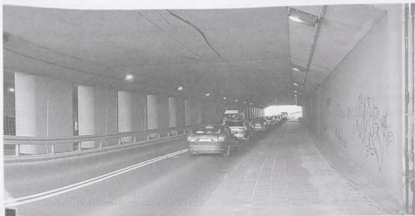
Obecna inwestycja Autostrady Wielkopolskiej SA nie przewiduje izolacji dużego, betonowego wiaduktu kolejowego (położonego pomiędzy ulicami Rivoliiego i Armii Poznań w pobliżu zjazdu z A2 Dębiec), który wielokrotnie potęguje hałas, odczuwalny aż na Świerczewie w Poznaniu
