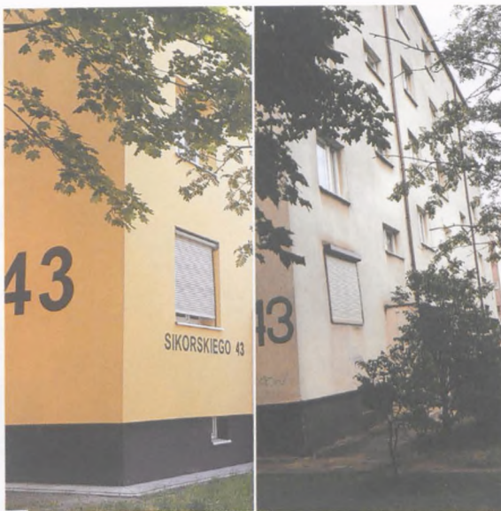
Termomodernizacja bloku przy ul. Sikorskiego 43 w 2017 r.
