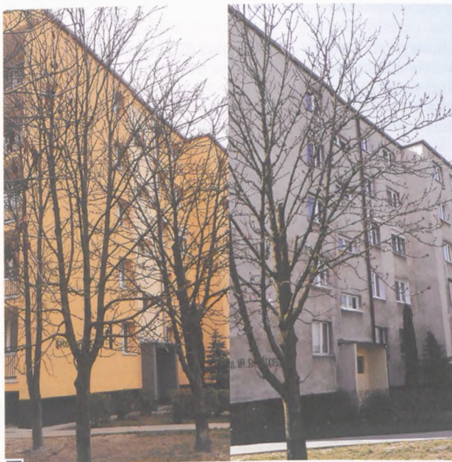
Termomodernizacja bloku przy ul. Sikorskiego 31
