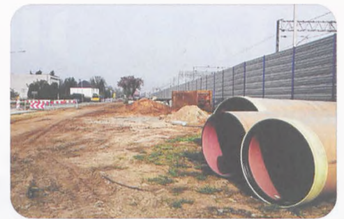
3. Inwestycja na ul. Dworcowej
