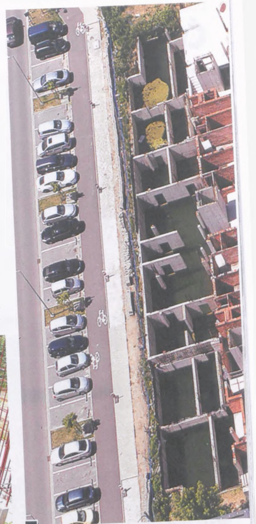
Na nieprzykrytej części podziemnej hali garażowej od strony ul. Wschodniej widać z lotu ptaka „kwitnienie” wody fot. Rafał Wojtyński
