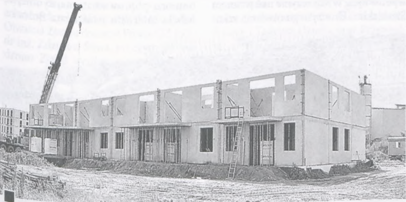
Zdjęcie wykonane 4 lipca, widać już ustawiane z prefabrykatów ściany nośne drugiej kondygnacji. Została więc jeszcze trzecia – ostatnia – są więc duże szanse na dotrzymanie ostatecznego terminu fot. Piotr P. Ruskowski
