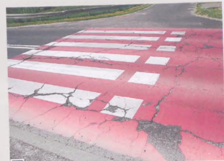
Kosztowna technologia trwałej (nie jedynie malowanej) zebra przejścia dla pieszych i przeprawy rowerowej niszczone na skutek złej jakości samej jezdni fot. Hanna Siatka
