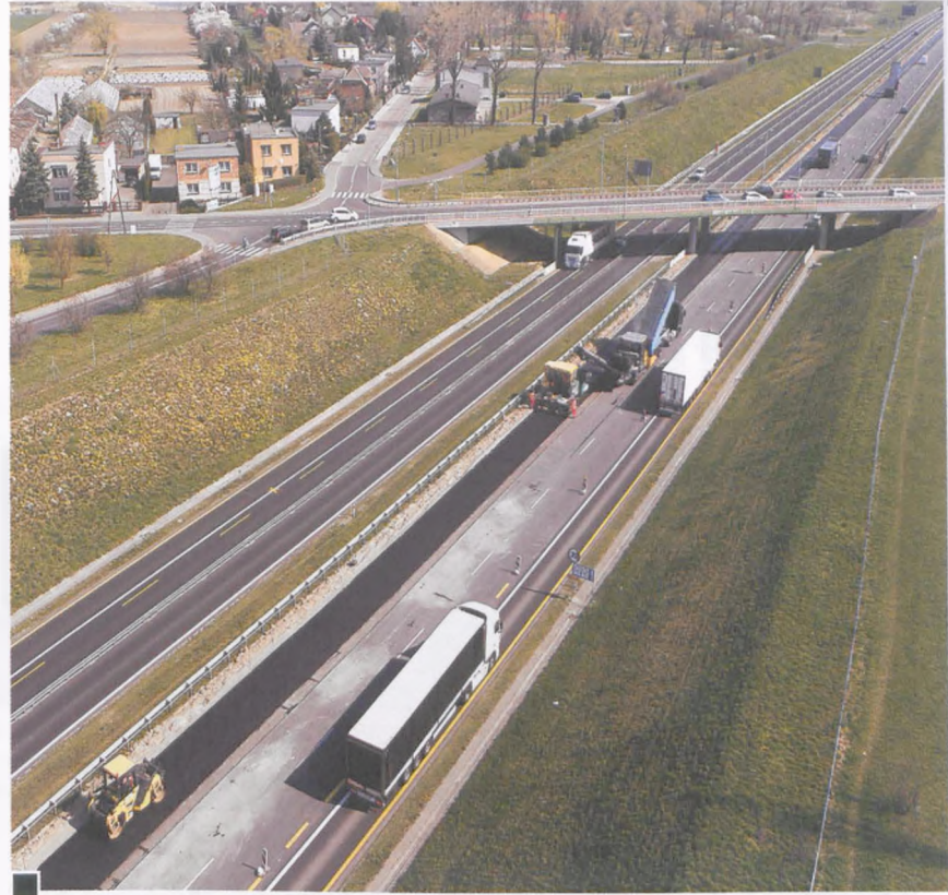
Budowa 3. pasa na autostradzie – widok z dronu operującego na wysokości kościola św. Barbary w kierunku wiaduktu ul. Kościuszki nad A2, z lewej – ul. Niezłomnych z muzeum. Na czas remontu ruch na autostradzie odbywa się jednym pasem (poboczem). Od wewnętrznej strony A2 trwa układanie asfaltowej nawierzchni dodatkowego pasa fot. Rafał Wojtyniak
