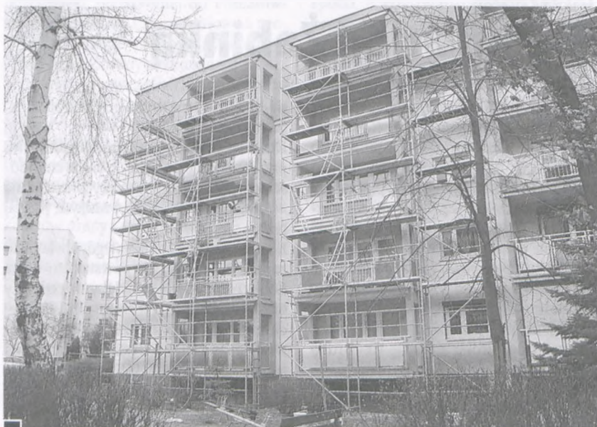
Remonty balkonów w Luboniance, na zdjęciu blok przy ul. Sikorskiego 9 (w ubiegłym roku ze wzgl. na stan balkonów przerwano remont elewacji) fot. Hanna Siatka
