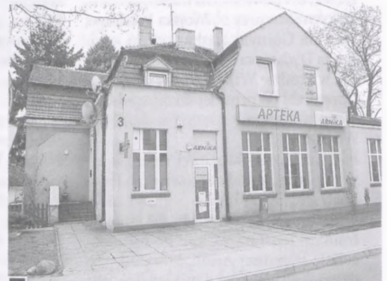
Pusty budynek po historycznej aptece w Żabikowie, nieczynnej od 2016 roku, w której przed wojną pracował Wincenty Pujanek fot. Hanna Siatka
