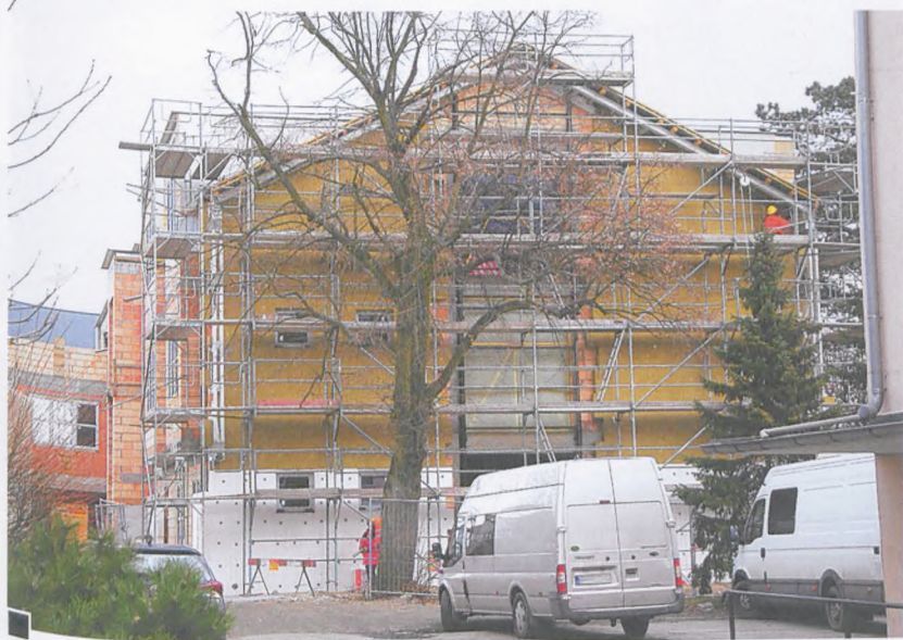
Ocieplany już szczyt od ul. Zielonej (południa) fot. Hanna Siatka
