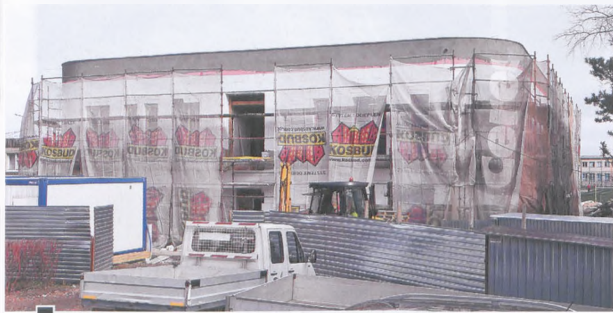
Stan inwestycji na początku marca br. – na dziedzińcu istniejącego przedszkola – gotowa bryła budynku ocieplana styropianem; widok od strony południowo-zachodniej. Przypomnijmy, że wykonawca jest rodzima firma „Przybeccy” z ul. Topolowej fot. Piotr P. Ruszkowski
