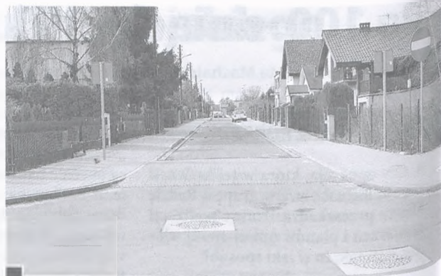
Utwardzana ul. Dojazdowa – widok od strony Rydla. Dwustronny chodnik oraz jednokierunkowa, 5-metrowej szerokości jezdnia z ruchem od ul. Sobieskiego. Na wyniesieniach z czerwonego bruku – przejścia dla pieszych fot. Piotr P. Ruskowski
