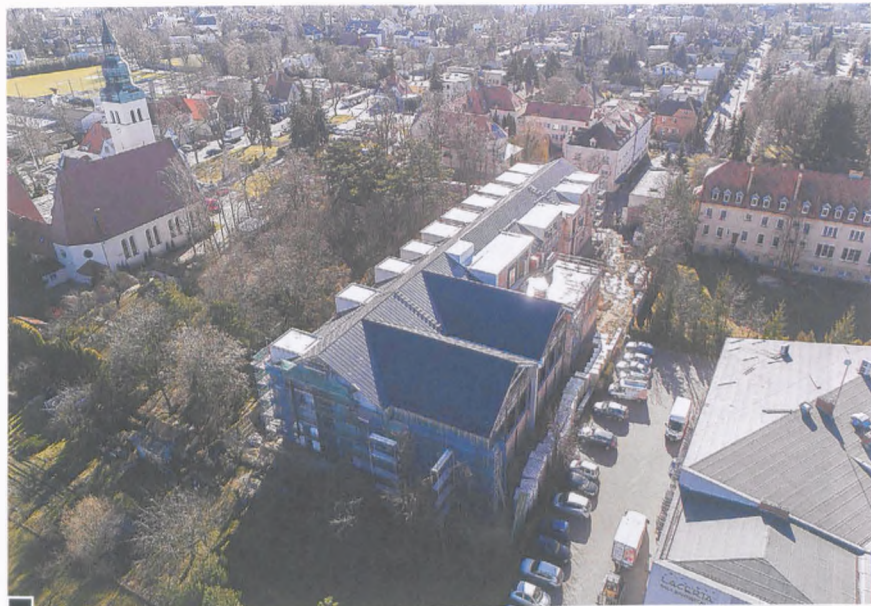
Pod dachem niemal zamknięta bryła przyszłej szkoły katolickiej w Żabikowie. Z lewej – kościół pw. św. Barbary, z prawej – zielony dach sali bankietowej „Lacerta” fot. Rafał Wojtyniak
