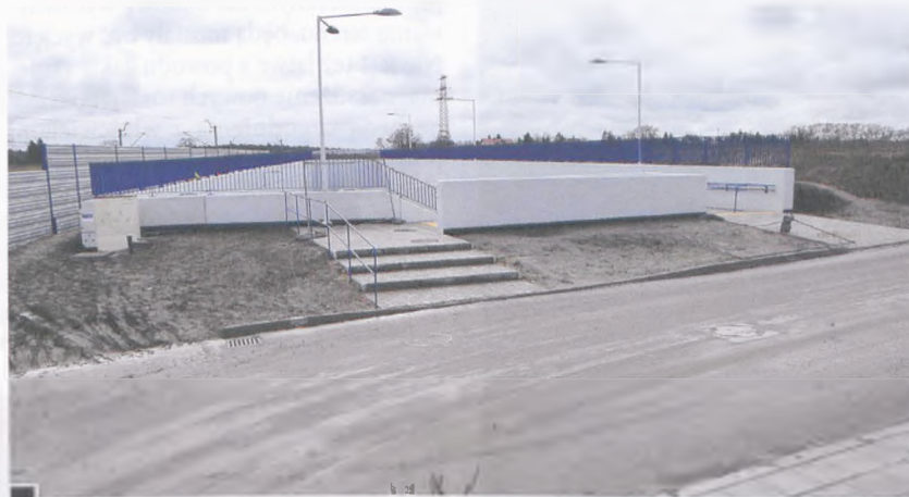
Od zachodniej strony ul. Podgórnej są dwa wejścia do podziemnego tunelu. Jedno wyżej, dalej od torów to pochylnia przeznaczona dla wózków osób niepełnosprawnych i dziecięcych oraz rowerów, rolek. W przyszłości, w tym miejscu będą musiały powstać, oddalone od siebie o kilkanaście metrów, dwa przejścia przez jezdnię w ul. Podgórnej fot. Piotr P. Ruszkowski
