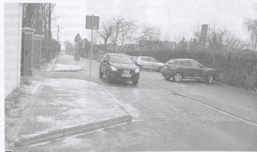
Nowość – wysepki przy wejściu na cmentarz od strony ul. Traugutta z wyniesionym przejściem dla pieszych, jednocześnie pełniącym rolę spowalnicza ruchu (muldy). Na razie, jako jedyne na całej długości ulicy stanowią niemałą pułapkę – skarżą się nie tylko kierowcy fot. Piotr P. Ruszkowski
