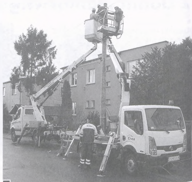
PAW Montaż nowego, masywnego słupa fot. Paweł Wolniewicz
