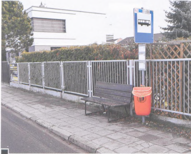
Przykład przystanku autobusowego „na żądanie” w Lasku (ul. Kwiatowa), gdzie na wąskim chodniku stoi szeroka i wygodna ławka. Jednak można, jak się chce? fot. Piotr P. Ruszkowski
