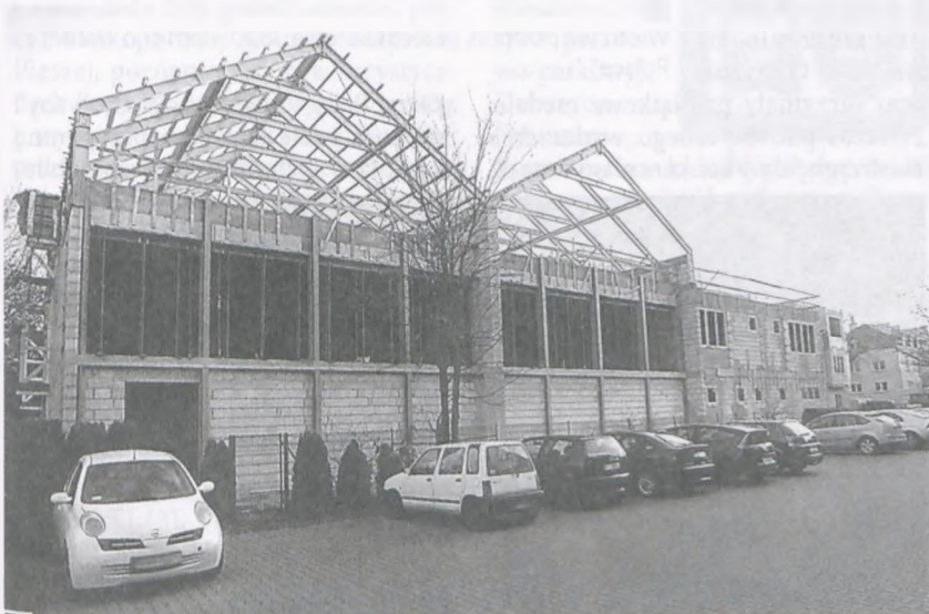
Widok budowanej szkoły katolickiej od ul. Przy Autostradzie. Od strony klasztoru (na zdjęciu – z prawej) konstrukcja dachu jest systematycznie przykrywana fot. Hanna Siatka
