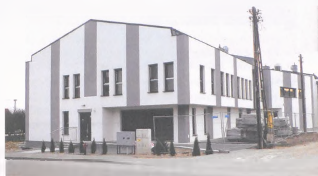
Kompleks przyszłych przychodni specjalistycznych z przedszkolem i apteką przy ul. Żeromskiego, w sąsiedztwie podobnej placówki („Med-Lux”) przy ul. Fabrycznej – widok z ul. Konarzewskiego fot. Hanna Siatka
