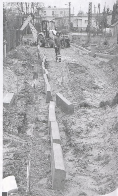
■ Po sznurku, na betonowej podsypce układa się obustronnie krawężniki oddzielające przyszłą jezdnię od chodników. Na zdjęciu budowa odcinka ul. Tuwima pomiędzy ul. Spadzistą a Cichą fot. Piotr P. Ruszkowski
