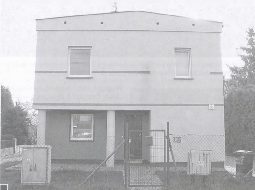
Nowa elewacja ściany frontowej z trudnymi do usunięcia zalekami po rozbitym jaju pomiędzy oknami fot. Paweł Wolniewicz
