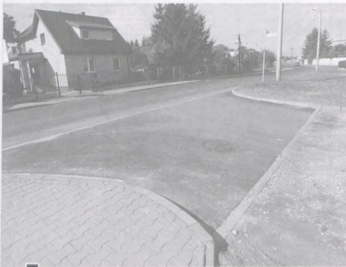
Remont wyjazdu z ul. Granicznej w Cmentarną znacznie poprawił komfort korzystania ze skrzyżowania. Zlikwidowano dziury na styku ruchliwych dróg – niebezpieczne dla układów zawieszania pojazdów fot. Hanna Siatka
