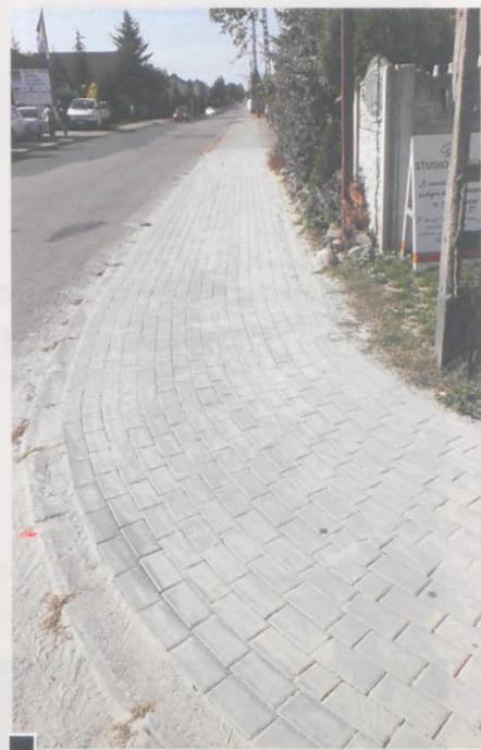
Wyremontowany fragment chodnika na ul. 11 Listopada na skrzyżowaniu z ulicą Wisławy Szymborskiej. Przechodnie nie mogli się doczekać poprawy od wielu lat – fot. Hanna Siatka
