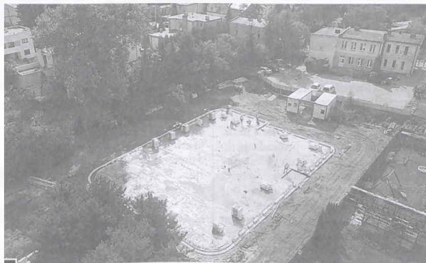
Plac budowy nowego przedszkola przy ul. Sobieskiego
