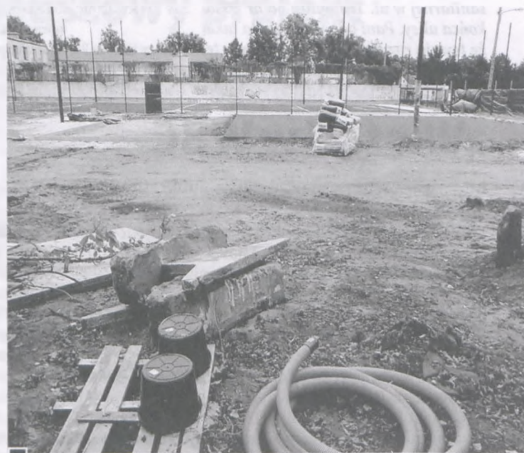
Rozpoczęta inwestycja sportowo-rekreacyjna przy ul. Kołłątaja w miejscu uczęszczanego placu zabaw. Miała być gotowa na koniec września fot. Hanna Siatka
