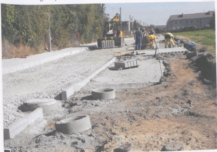
Realizowany fragment ul. Kurowskiego od ul. Sobieskiego. Z lewej widoczny chodnik, z prawej – chodnik i parkingi w budowie fot. Hanna Siatka
