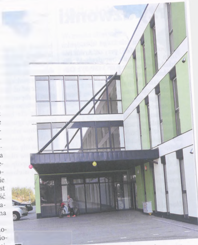
Budując Ośrodek przystosowany dla osób niepełnosprawnych pomyślano o dużym zadaszaniu wejścia, pod które może bezpośrednio podjechać samochód. Zastosowano podciąg, który pozwolił na niemontowanie filaru, ograniczającego przestrzeń fot. Piotr P. Ruszkowski
