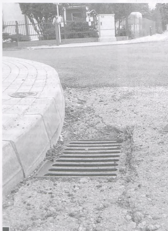
10 września na odcinku ul. Lipowej pomiędzy Zieloną i Poniatowskiego położono wreszcie asfalt. Obok, na łuku drogi, przy wysokim krawężniku od ul. Zielonej, pomimo interwencji mieszkańca, pozostała niebezpieczna zapadlina nawierzchni z kanałem ściekowym fot. Hanna Siatka
