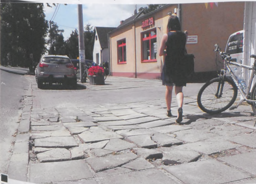
Zdevastowane przez ciężkie samochody dojście do sklepu w Żabikowie fot. Hanna Siatka
