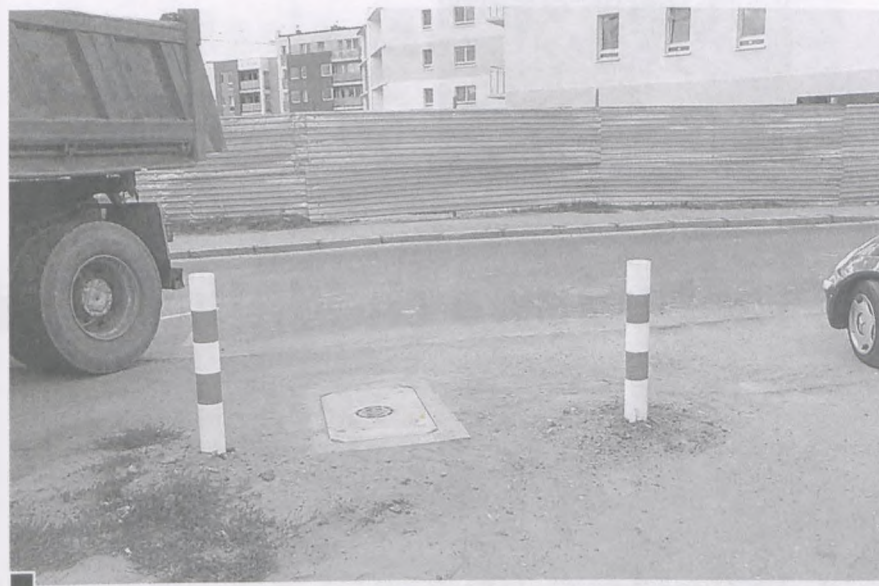
Naprawiona niedawno studzienka telekomunikacyjna przy ul. Pułaskiego, położona na wjazdach na plac z materiałami do budowy i parking fot. Hanna Siatka
