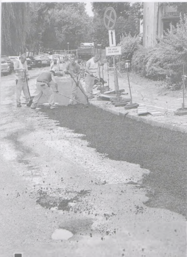
W deszczowy dzień, 11 lipca, ul. Osiedlową wypełniano warstwami masy bitumicznej fot. Piotr P. Ruskowski
