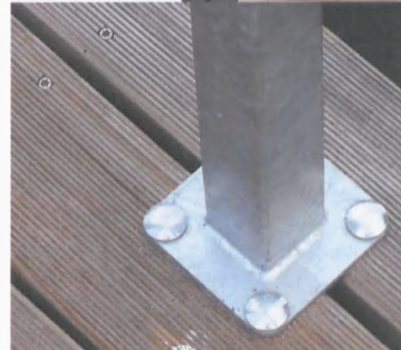
Leniwy spokój tego miejsca mać stan zabezpieczenia pływającego pomostu. O ile barierki wzdłuż platformy są dość solidnie zespolone z konstrukcją, o tyle boczne balustradki, przytwierdzone do podłoża czterema śrubami, bez spojenia z poprzecznymi poręczami, chwiania się i przy mocniejszym pchnięciu mogą ustąpić... fot. Hanna Siatka
