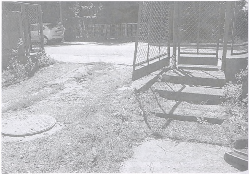
Jedną z przyczyn zalewania posesji przy ul. Ks. Streicha 27 – położenie poniżej poziomu drogi. Przy dużych opadach woda przelewa się przez chodnik i nachylonym podłożem wpływa na podwórze. Zalany plac za domem zamienia się w jezioro, przez które trudno przedostać się do garaży i ogrodów fot. Hanna Siatka
