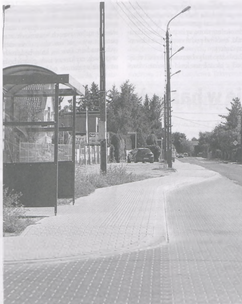
Zrealizowana inwestycja chodnika na ul. Sobieskiego
