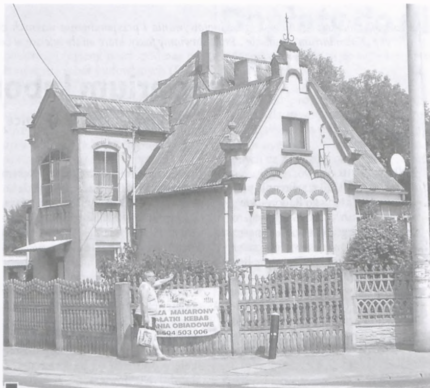
Oryginalna, zachowana z okresu budowy Kolonii Żabikowo architektura budynku mieszkalnego przy ul. 11 Listopada (narożnik Szkolnej), niegdyś – „Villa Erika”. Zmieniono jedynie okna i poszycie dachu
