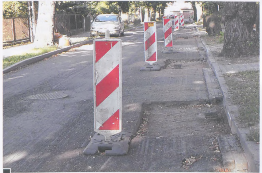
Sfrezowany ponad miesiąc temu asfalt na ul. Lipowej z pogłębionymi fragmentami przy wystających studzienkach fot. Hanna Siatka
