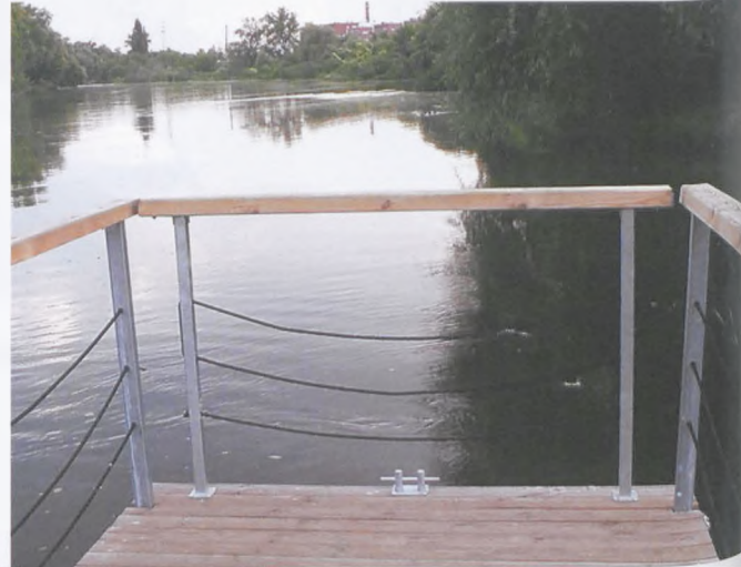
Leniwy spokój tego miejsca mać stan zabezpieczenia pływającego pomostu. O ile barierki wzdłuż platformy są dość solidnie zespolone z konstrukcją, o tyle boczne balustradki, przytwierdzone do podłoża czterema śrubami, bez spojenia z poprzecznymi poręczami, chwiania się i przy mocniejszym pchnięciu mogą ustąpić... fot. Hanna Siatka
