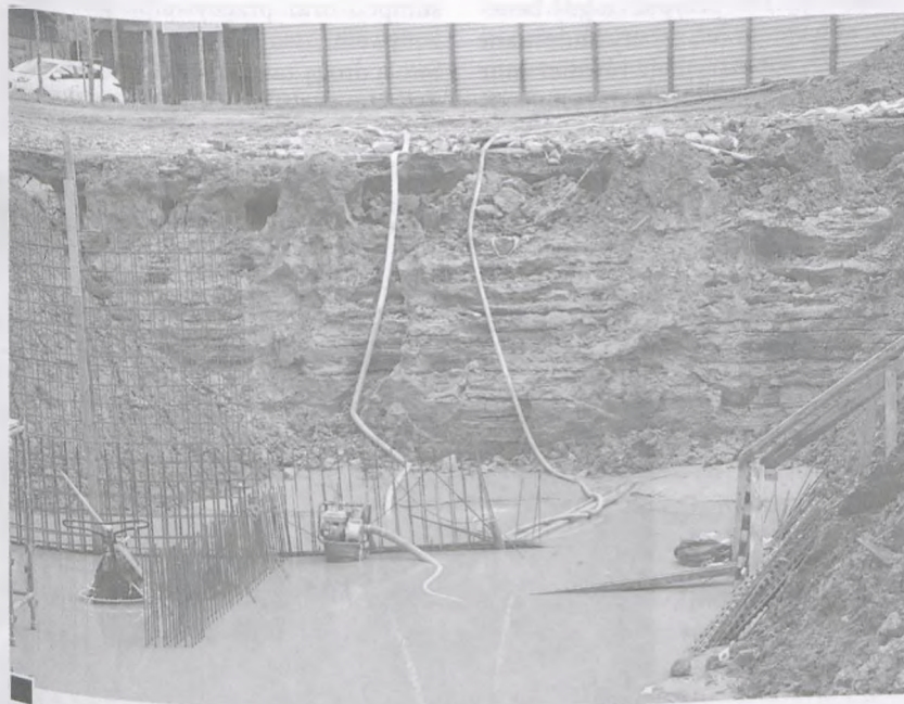
Wyplukane przez deszcz mniej zwięzłe frakcje gliny widoczne w przekroju wykopu, oraz pompy, które węzami tłoczyły pod górę tysiące litrów zamulonej wody fot. Piotr P. Ruskowski
