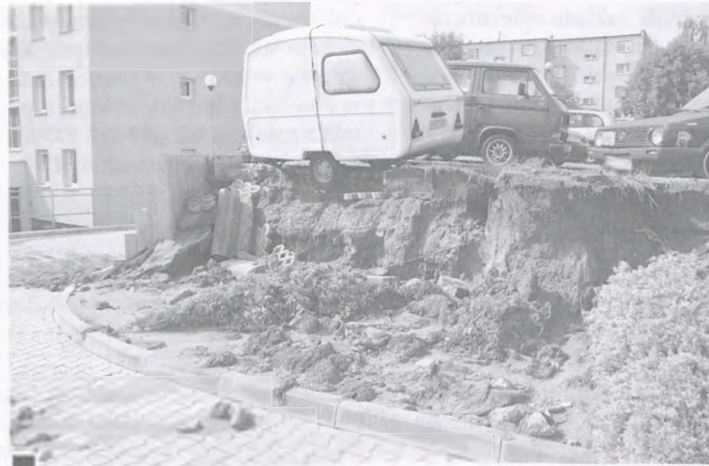
Podmyta przez wodę z zapchanej studzienki, świeżo usypana skarpa przy nowym dojeździe do ROD „Bratek” na ul. Sikorskiego (czytaj na str. 17). Tylko dzięki zablokowaniu koła przez obsuniętą płytę z parkingu, przyczepa kampingowa nie runęła. O dopiero co zakończonej inwestycji czytaj na str. 17 fot. Piotr P. Ruszkowski
