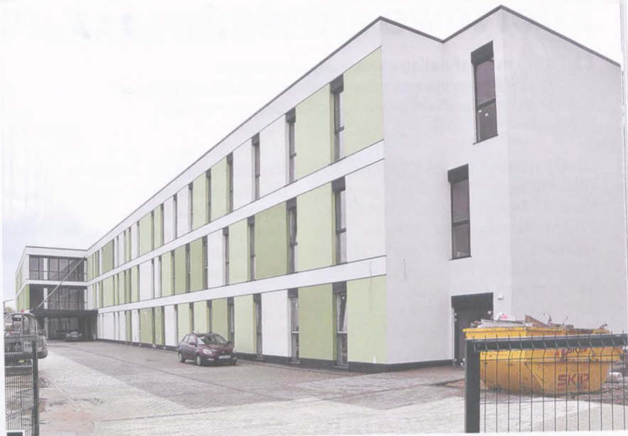
Budynek OREW EMEDEA o długości 100 m, powstały za Ośrodkiem Kultury przy ul. Sobieskiego, zostanie otwarty już we wrześniu
