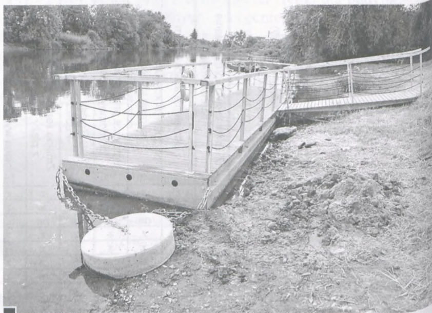
Pływający pomost na plaży miejskiej, praktycznie tylko widokowy (obwarowany wieloma zakazami zapisanymi w powyższym regulaminie). Zgodnie z zapowiedzią z 2016 r., miał to być przystanek dla tramwaju wodnego z Poznania. Ze względu na niski poziom Warty konieczne było podkopanie brzegu, by pomost niebezpiecznie nie przechylił się w stronę nurtu. fot. Piotr P. Ruszkowski
