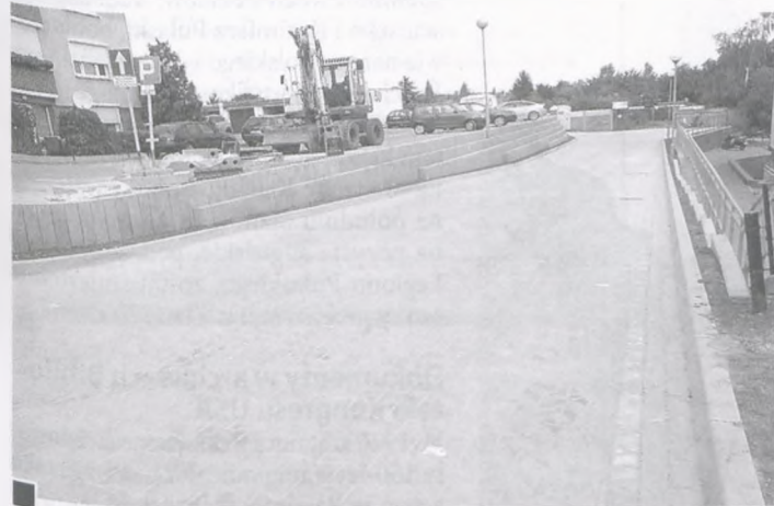
Nowa, boczna droga od ul. Sikorskiego do Rodzinnego Ogrodu Działkowego „Bratek”. W głębi – brama wjazdowa Ogrodu i niewidoczne, za skarpe po lewej stronie, przy ogrodzeniu ROD – miejsca parkingowe (postój przewidziano także wzdłuż drogi) fot. Hanna Siatka
