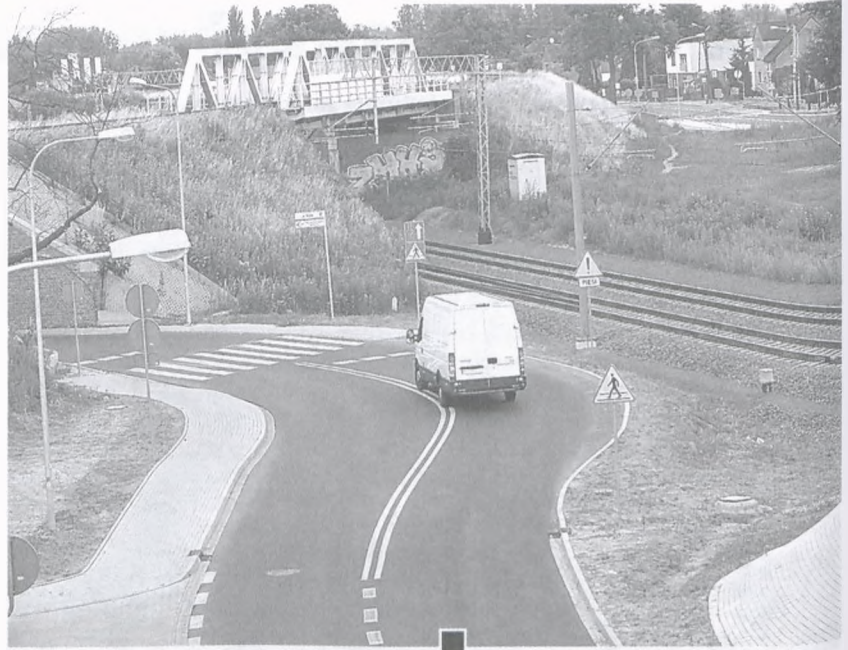
Przejście dla pieszych przez ul. Krętą (z lewej) prowadzi wprost na tory kolejowe, po których całkiem często kursują pociągi Poznań-Wrocław. Ze skrótu w kierunku ul. Armii Poznań (w głębi) korzystają również dzieci...! fot. Hanna Siatka
