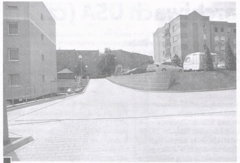
Widok drogi do ROD „Bratek” w kierunku ul. Sikorskiego. Po lewej blok Spółdzielni Mieszkaniowej z adresem: ul. Sikorskiego 30b, z prawej, na palisadowej skarpie – osiedlowy parking i tzw. „zielone bloki”. Na nieutwardzonej części skarpy po prawej, przy garażach, miały powstać schody, z których jednak zrezygnowano. Odnosnie tego miejsca patrz też str. 31 – „Żywiół wygrywa” fot. Hanna Siatka
