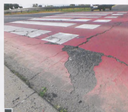
Spowodowane pękaniem asfaltu ubytki w oznakowaniu przejścia dla pieszych przez ul. Unijną przy wejściu do parku Papieskiego na wysokości Rodzinnego Ogrodu Działkowego „Bratek” fot. Hanna siatka
