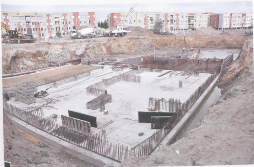
Plac budowy 2. etapu inwestycji firmy Immo Building – widok od strony ul. Mizerki, w tle bloki przy al. Jana Pawła II fot. Piotr P. Ruszkowski
