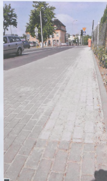
Uzupełniony do pełnej szerokości chodnik z jaśniejszej kostki, w ul. Dąbrowskiego fot. Piotr P. Ruszkowski
