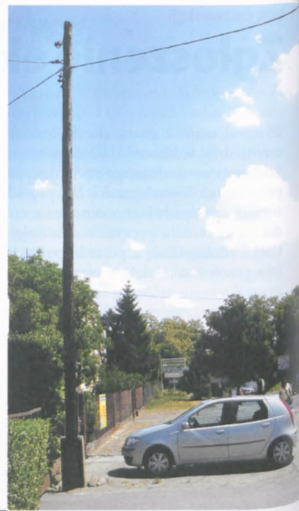
Stary, drewniany słup jest coraz bardziej krzywy. Na całej wysokości słupa są widoczne liczne pęknięcia i uszkodzenia struktury fot. Paweł Wolniewicz
