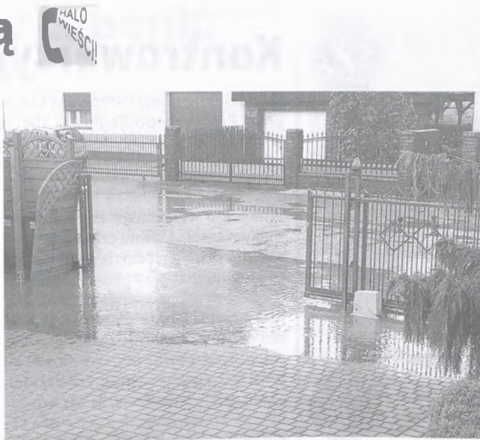
Fragment ul. Spornej, na której nieodpowiednio wyprofilowany chodnik z jezdnią powodują zalewanie posesji fot. Agnieszka Wójcik
