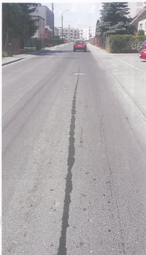
Ślady wyciekłego oleju na ul. Wschodniej w kierunku Pułaskiego (pogotowia ratunkowego) oraz na ul. Pułaskiego w stronę nowego ronda fot. Jacek Mystkowski
