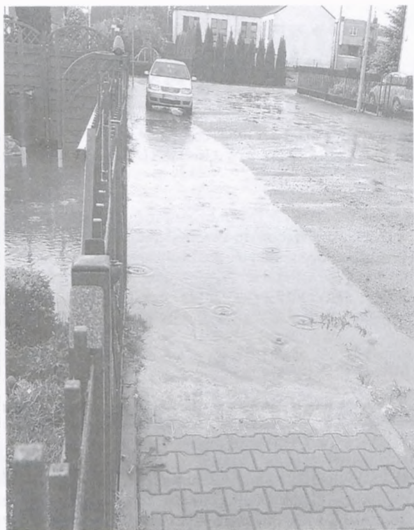
Fragment ul. Spornej, na której nieodpowiednio wyprofilowany chodnik z jezdnią powodują zalewanie posesji fot. Agnieszka Wójcik
