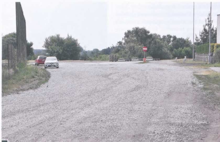
Tłuczniem wyrównana i utwardzona końcówka nie asfaltowej ul. Rzecznej (po prawej) kończąca się jedynie znakiem zakaz wjazdu, oraz parking usytuowany przy płocie boiska treningowego stadionu miejskiego (z lewej) fot. Piotr P. Ruszkowski
