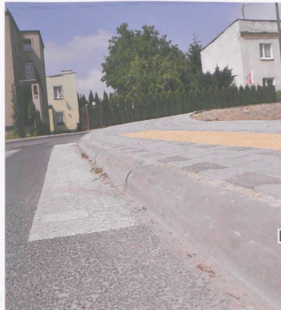
Nieprzyjazne, nowe przejście dla pieszych przy skrzyżowaniu z ul. Okrzei ze zbyt wysokim krawężnikiem fot. Piotr P. Ruszkowski
