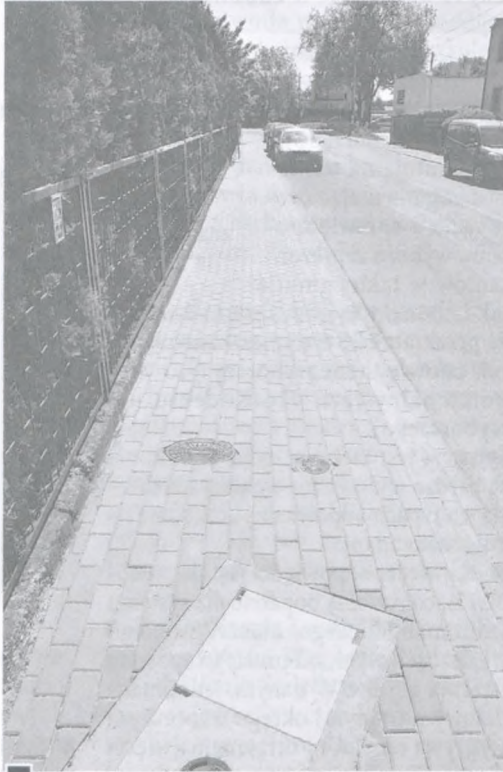
Odcinek wyremontowanego chodnika na ul. Dożynkowej – widok w kierunku ul. Armii Poznań fot. Piotr P. Ruskowski
