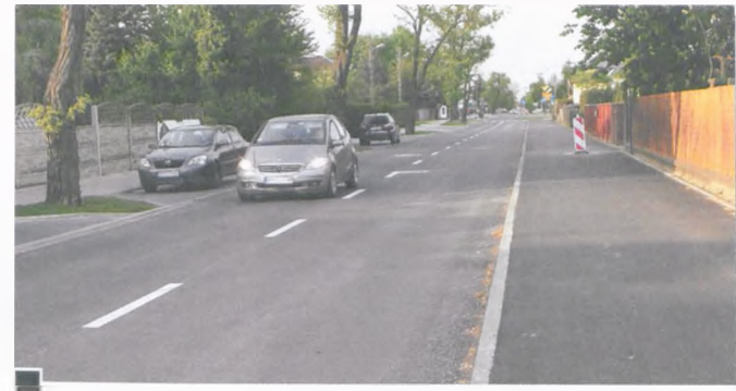
Nowa, asfaltowa droga ma z jednej strony szeroką ścieżkę rowerową, a z drugiej – chodnik i zatoczki z miejscami postojowymi dla samochodów (w tym dwa pola dla aut osób niepełnosprawnych) fot. Hanna Siatka
