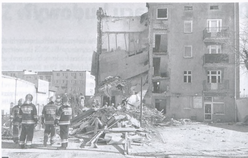
Kamienica po wybuchu gazu na sąsiednim Dębku została rozebrana. Są środki na pomoc dla mieszkańców
