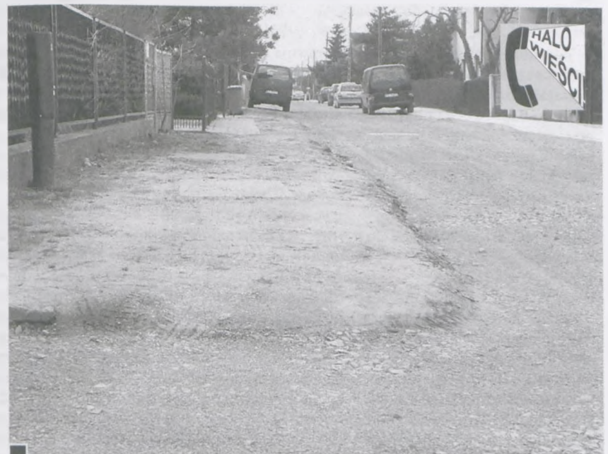
Na ul. Kasprzaka, w miejscu przyszłego chodnika, po zakończeniu inwestycji pozostawiono wyżej położone pobocze, zabezpieczając je przed gromadzeniem się wody fot. Hanna Siatka
