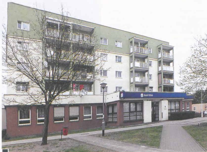
Przyziemie bloku przy ul. Sikorskiego 3, przez wiele lat zajmowane przez Bank PKO BP, prawdopodobnie kupi miasto fot. Hanna Siatka
