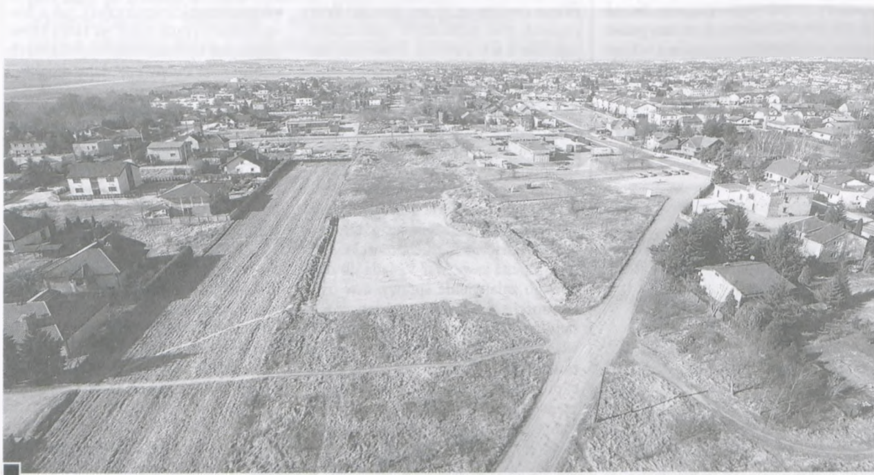
Obszar przy ul. Ogrodowej (gruntowej) wpadającej w ul. Fabryczną – sfotografowany z lotu ptaka. W głębi – stacja „Orlen” i ul. Sobieskiego. Po interwencjach mieszkańców, teren ten został uporządkowany przez miasto, by do czasu powstania planowanej Trasy Południowej (czytaj str. 14) mogło tu ponownie funkcjonować boisko do gry w piłkę fot. Rafał Wojtyniak
