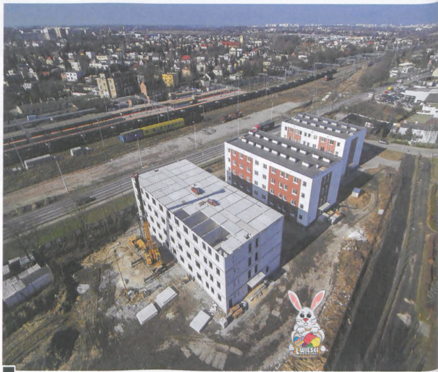
Powstaje trzeci budynek z lokalami typu Studio pomiędzy ul. Armii Poznań a Żeglarską fot. Rafał Wojtyński
