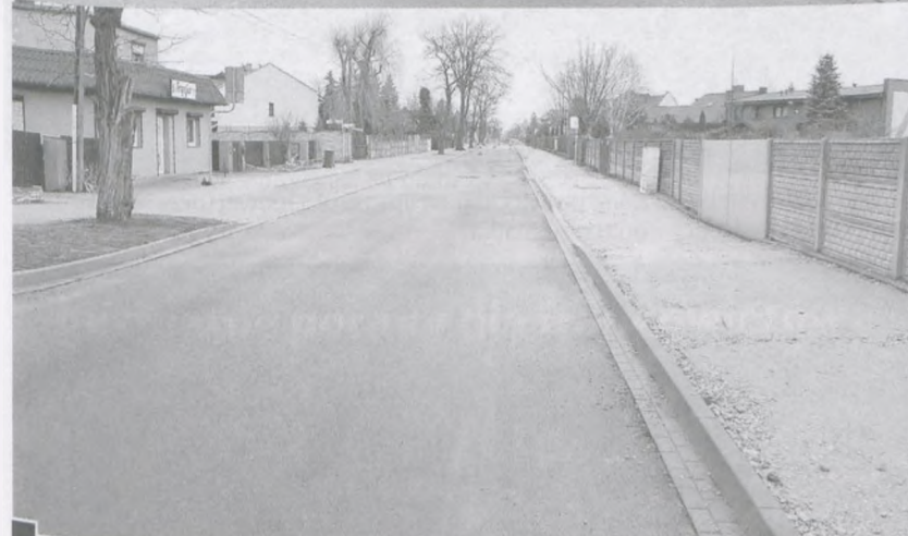
Na całej długości inwestycji w połowie marca nic się nie działo fot. Piotr P. Ruszkowski
