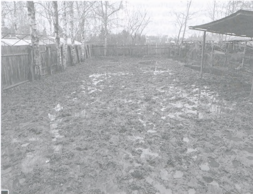
Posesja przy ul. Szymanowskiego – teren notorycznie podmokły na skutek przebranego systemu drenaży
