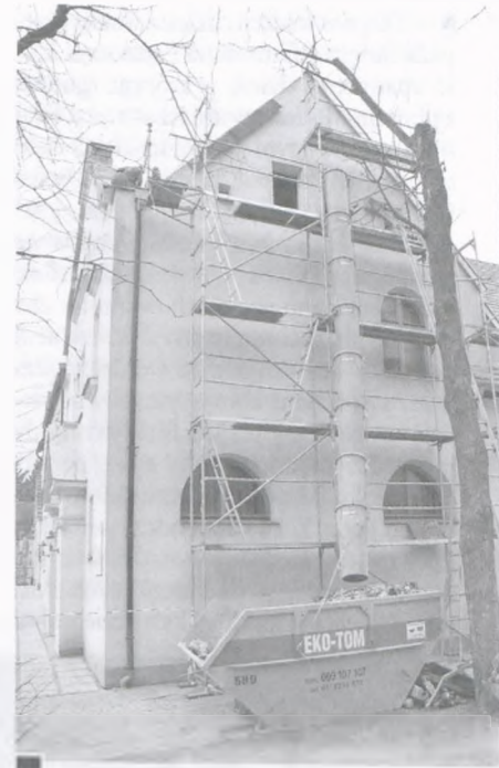
Remont dachu Sanktuarium bł. Edmunda fot. Piotr P. Ruszkowski
