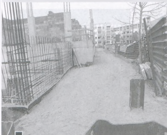
Zasypane fundamenty nieskończonego bloku przy ul. Wschodniej 19 w miejscu pokazującym przez nas wcześniej – po stronie wschodniej fot. Hanna Siatka
