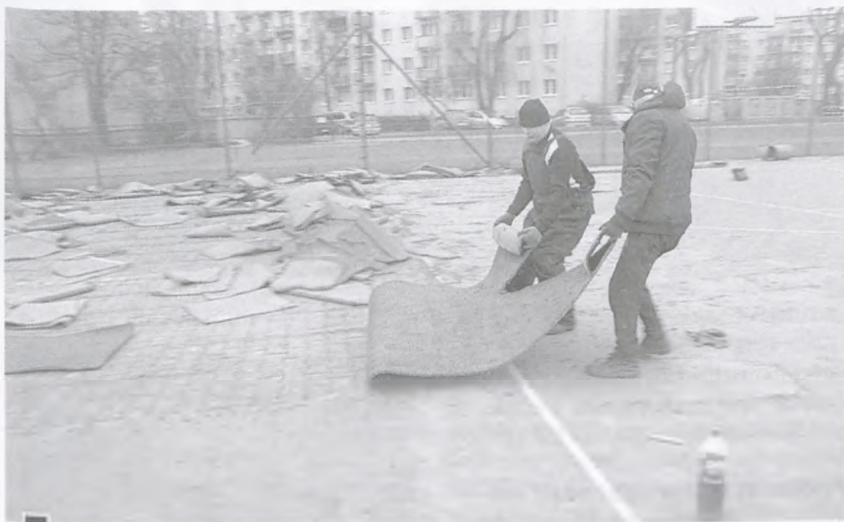
Zrywanie poprzedniej, sztucznej nawierzchni z płyty boiska sportowego przy Szkole Podstawowej nr 2 fot. Władysław Szczepaniak
