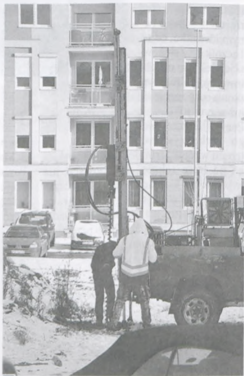
Odwierty w NCL zapowiadają budowę kolejnego bloku w ramach kontynuacji budownictwa wielorodzinnego przy ul. Andrzeja Mizerki fot. Piotr P. Ruszkowski
