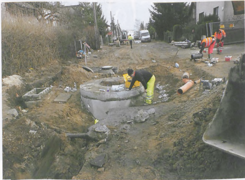
Montaż przepompowni ścieków deszczowych (2,5 m) o wydajności 75 dm 3 /s, wraz z wyposażeniem fot. Hanna Siatka
