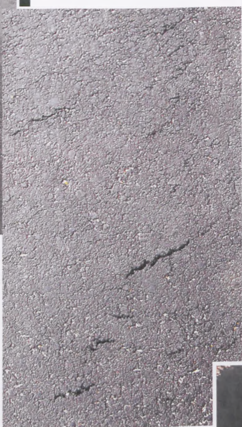
Asfalt na najnowszym rondzie – w ul. Pułaskiego i skrzyżowaniu z al. Jana Pawła II – został tak położony, że wymagał w kilku miejscach korekt – dodatkowych wycięć i powtórnych wypełnień. Uważny widz dostrzeże kliny nowej, naprawczej masy bitumicznej. Pomimo tych zabiegów, na niewielkim rondzie już tworzą się drobne kałuże. Eksploatacja nawierzchni z pewnością ich nie zniweluje, lecz z czasem zagłębienia staną się bardziej wyeksponowane fot. Piotr P. Ruszkowski
