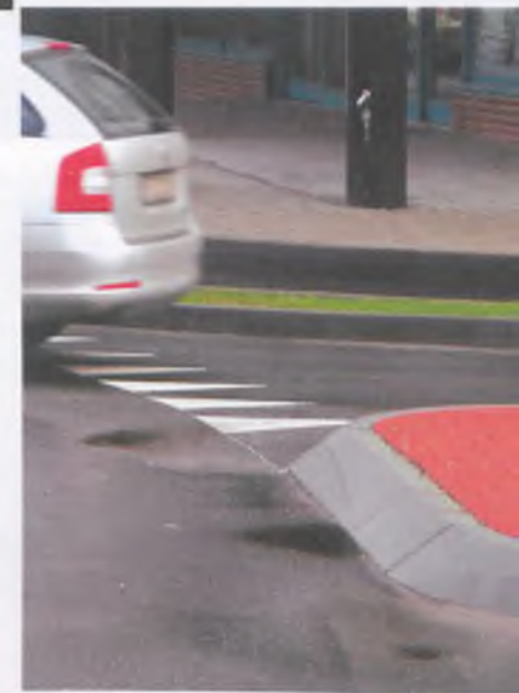
Asfalt na najnowszym rondzie – w ul. Pułaskiego i skrzyżowaniu z al. Jana Pawła II – został tak położony, że wymagał w kilku miejscach korekt – dodatkowych wycięć i powtórnych wypełnień. Uważny widz dostrzeże kliny nowej, naprawczej masy bitumicznej. Pomimo tych zabiegów, na niewielkim rondzie już tworzą się drobne kałuże. Eksploatacja nawierzchni z pewnością ich nie zniweluje, lecz z czasem zagłębienia staną się bardziej wyeksponowane fot. Piotr P. Ruszkowski
