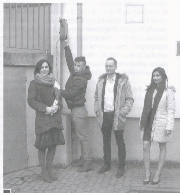
Joanna Cichoń i przedstawiciele firmy „Syngeos” podczas montażu czujnika badającego poziom zanieczyszczenia powietrza fot. Paweł Wolniewicz
