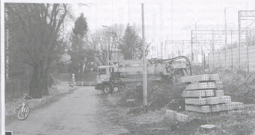
Pracownicy Wuko w akcji. Prace utrudniały zgromadzone na trasie przebiegu kanału odwodnieniowego materiały zgromadzone na potrzeby prowadzonej tu inwestycji, które trzeba było przemieścić, żeby dostać się do zlokalizowanych tam studzienek fot. Paweł Wolniewicz
