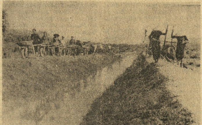
Budowa 50-kilometrowego kanału nawadniającego w pobliżu zaopory na rzece Nam Ron. CAF — Via
