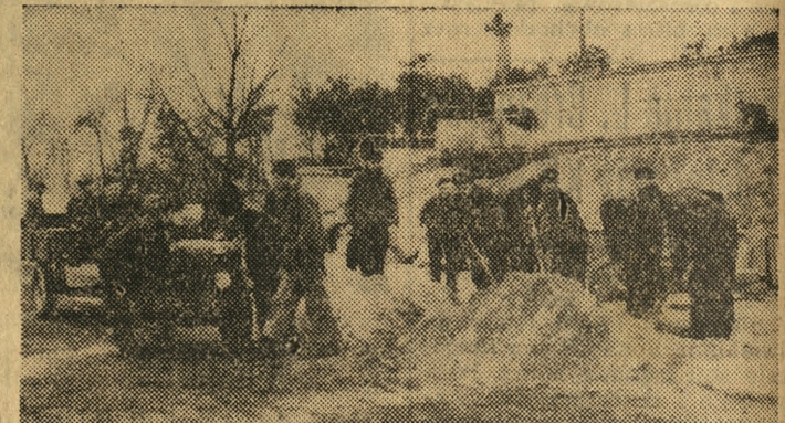
Na zdjęciu przedstawiciele kocińskich zakładów przy pracach remontowych miejscowego stadionu sportowego.
