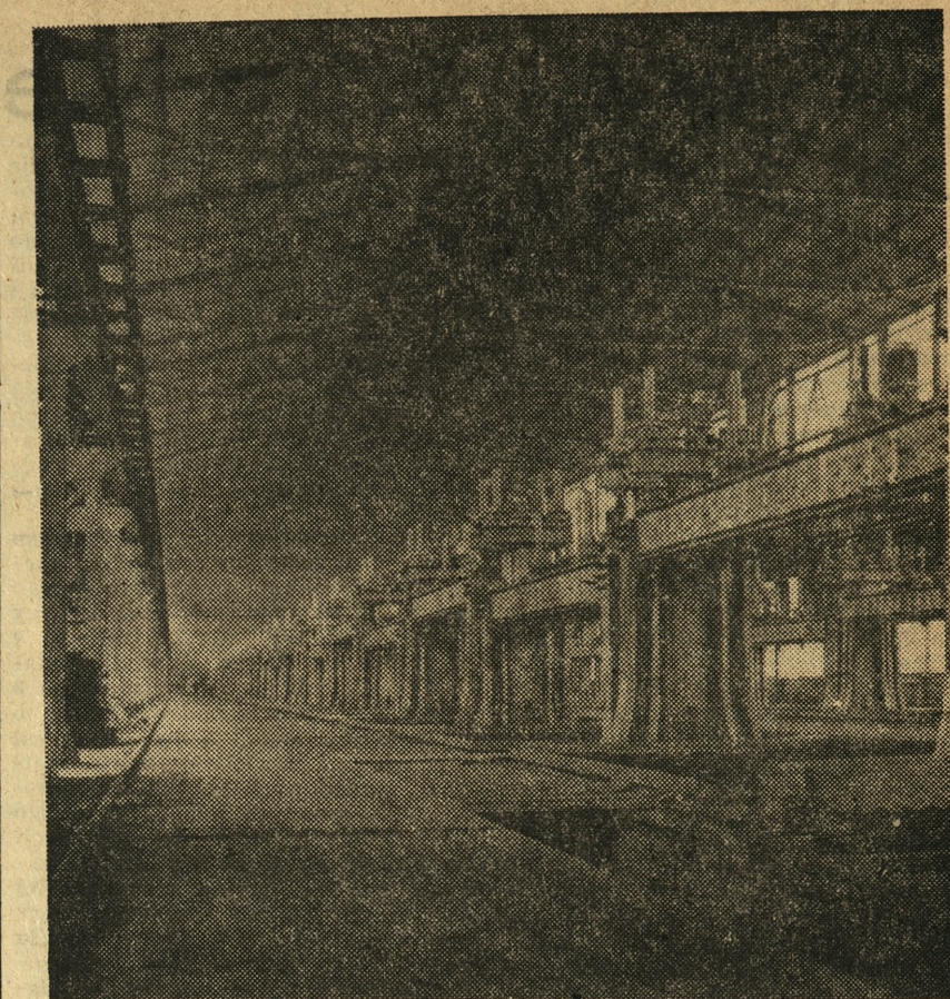
Fragment hali elektrolizy, zasadniczego działu produkcji srebrzystego metalu w hucie aluminium w Koninie, która ruszy w najbliższą środę.
