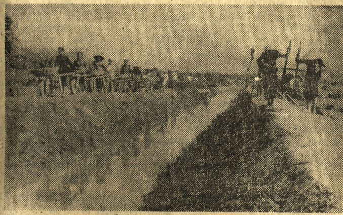
Budowa 50-kilometrowego kanału nawadniającego w pobliżu za-pory na rzece Nam Ron. CAF — Via
