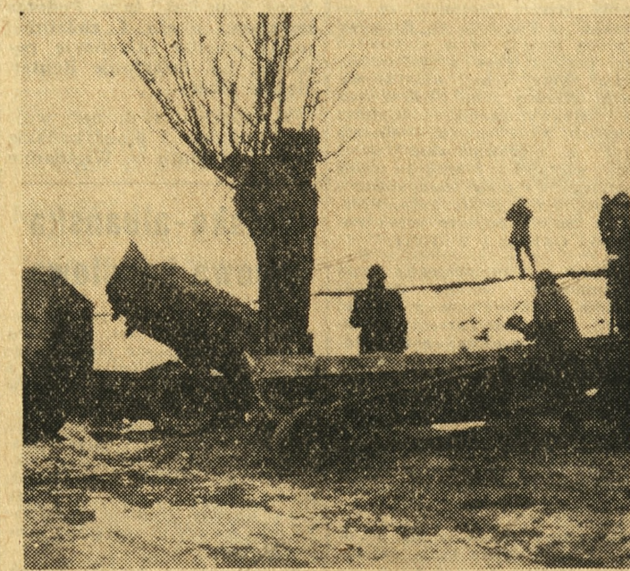
Od 2 tygodni trwa alarm przeciwpowodziowy w pow. kozienickim (Kieleckie). Szczególnie groźna jest sytuacja w GRN Zajezerze, a zwłaszcza we wsi Kamelonka, gdzie zaczynała przeciekać wały. Na zdjęciu: wywrotka wyrzuca piasek w miejscach, gdzie przecieka wał.
