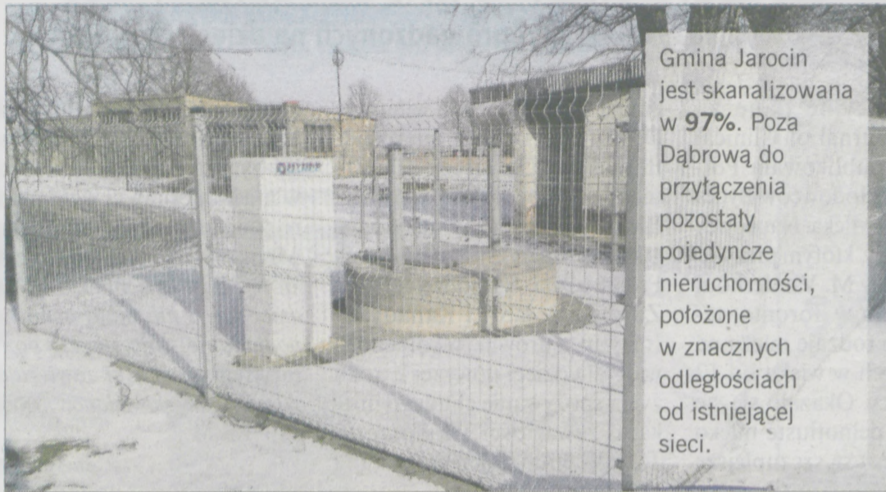
W ramach budowy kanalizacji w Wilczyńcu powstały cztery przepompownie
