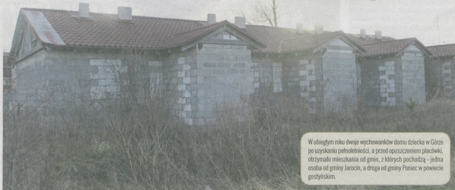
Niedokończony budynek w Mieszkowie czeka na gospodarza
