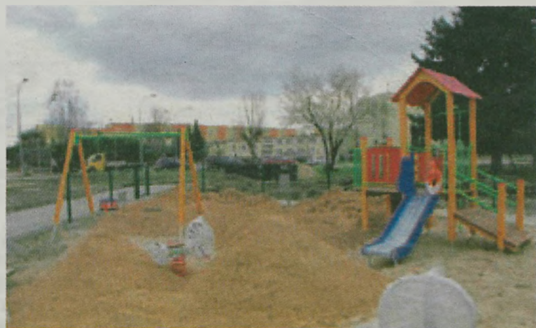
Plac zabaw dla dzieci w trakcie realizacji
