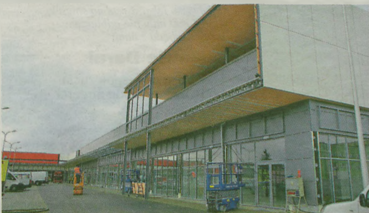
Prace na budowie postępują w zawrotnym tempie
